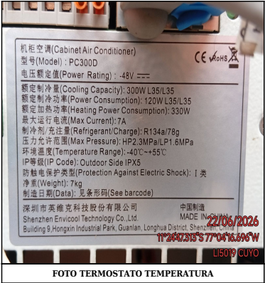
FOTO TERMOSTATO TEMPERATURA
