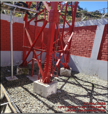
Foto Panorámica del Interior del Site
