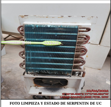
FOTO LIMPIEZA Y ESTADO DE SERPENTIN DE UC
