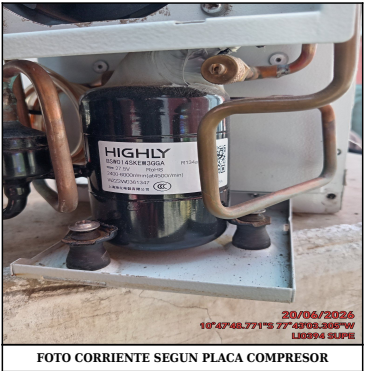
FOTO CORRIENTE SEGUN PLACA COMPRESOR
