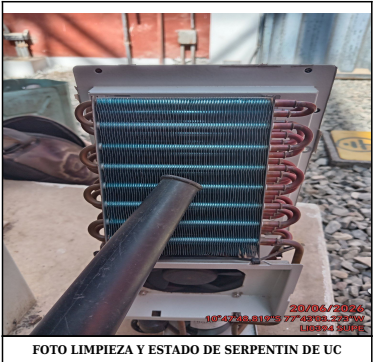
FOTO LIMPIEZA Y ESTADO DE SERPENTIN DE UC
