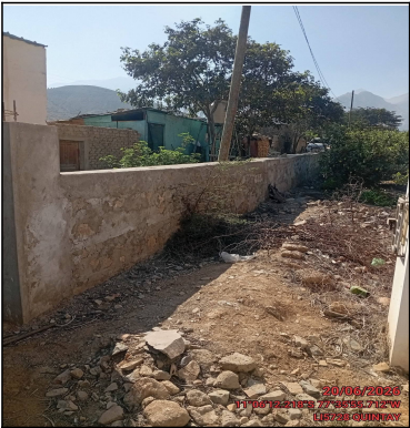
Pozo a tierra
