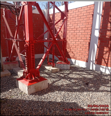
Foto Panorámica del Interior del Site
