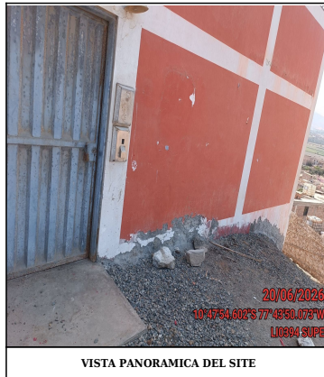
VISTA PANORAMICA DEL SITE
