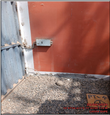
Foto Panorámica del Interior del Site
