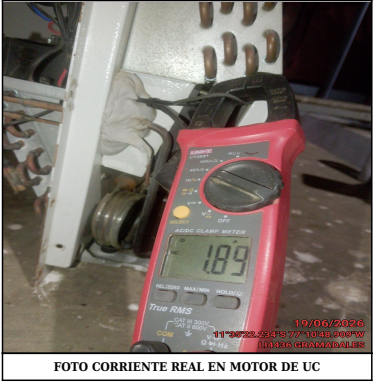
FOTO CORRIENTE REAL EN MOTOR DE UC
