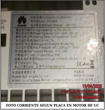
FOTO CORRIENTE SEGUN PLACA EN MOTOR DE UC
