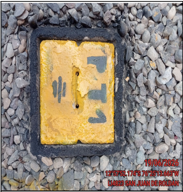
Pozo a tierra
