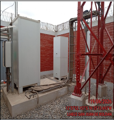
Foto Panorámica del Interior del Site
