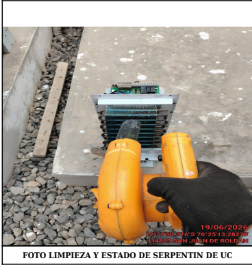
FOTO LIMPIEZA Y ESTADO DE SERPENTIN DE UC
