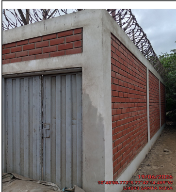
VISTA PANORAMICA DEL SITE
