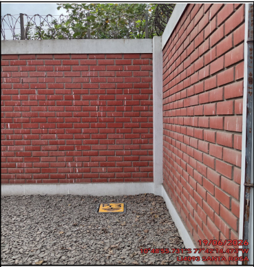
Foto Panorámica del Interior del Site
