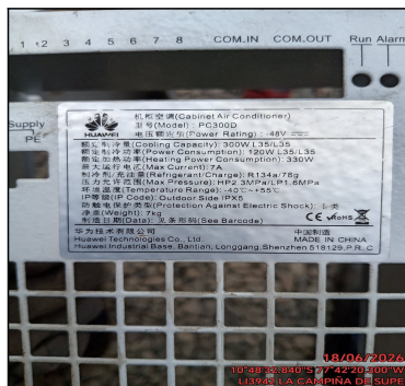
FOTO DE PLACA DE UNIDAD EVAPORADORA
