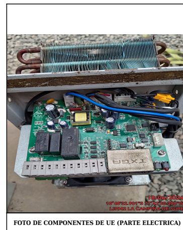
FOTO DE COMPONENTES DE UE (PARTE ELECTRICA)
