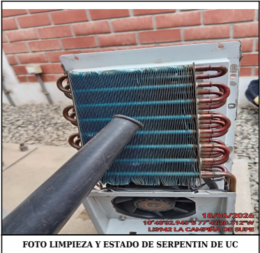
FOTO LIMPIEZA Y ESTADO DE SERPENTIN DE UC
