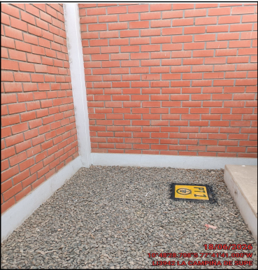
Foto Panorámica del Interior del Site
