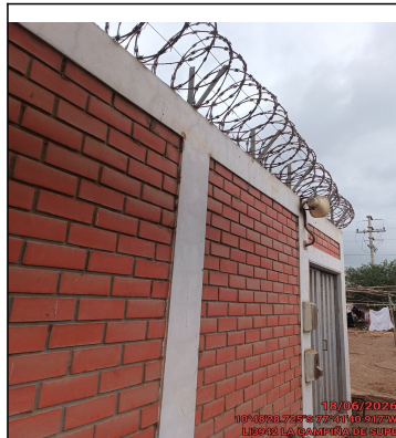
VISTA PANORAMICA DEL SITE
