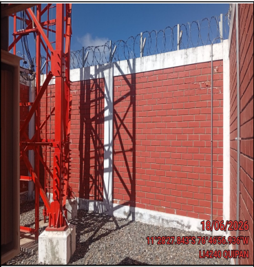
Foto Panorámica del Interior del Site
