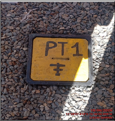
Pozo a tierra
