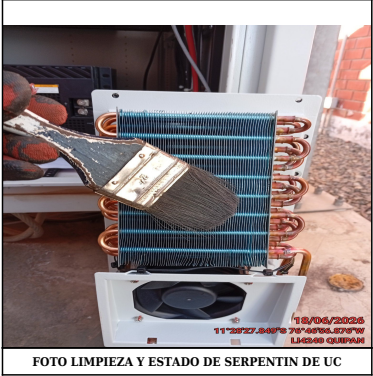
FOTO LIMPIEZA Y ESTADO DE SERPENTIN DE UC
