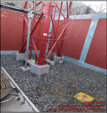
Foto Panorámica del Interior del Site
