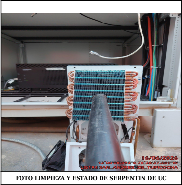
FOTO LIMPIEZA Y ESTADO DE SERPENTIN DE UC
