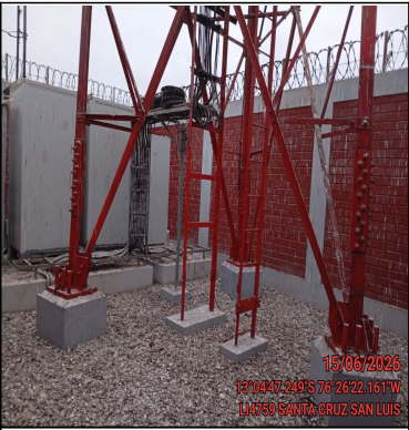
Foto Panorámica del Interior del Site
