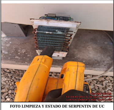
FOTO LIMPIEZA Y ESTADO DE SERPENTIN DE UC
