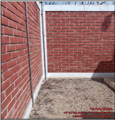
Foto Panorámica del Interior del Site
