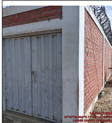
VISTA PANORAMICA DEL SITE
