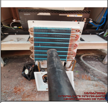
FOTO LIMPIEZA Y ESTADO DE SERPENTIN DE UC
