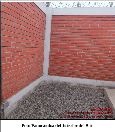
Foto Panorámica del Interior del Site
