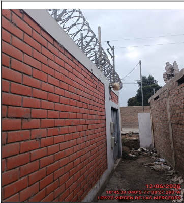
VISTA PANORAMICA DEL SITE
