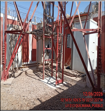
Foto Panorámica del Interior del Site
