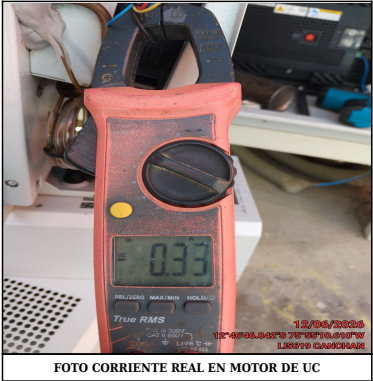
FOTO CORRIENTE REAL EN MOTOR DE UC
