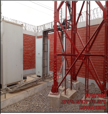
Foto Panorámica del Interior del Site
