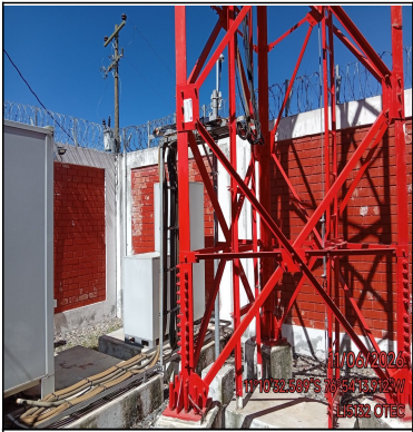
Foto Panorámica del Interior del Site
