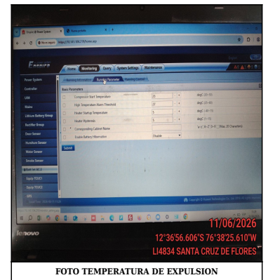
FOTO TEMPERATURA DE EXPULSION
