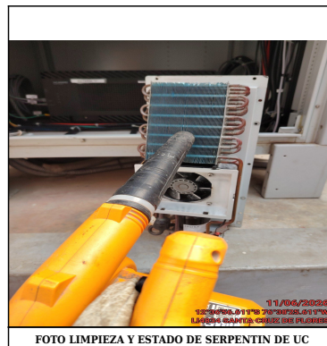
FOTO LIMPIEZA Y ESTADO DE SERPENTIN DE UC
