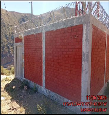
Pozo a tierra
