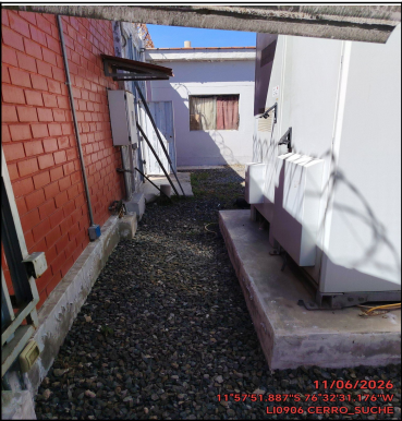
Foto Panorámica del Interior del Site
