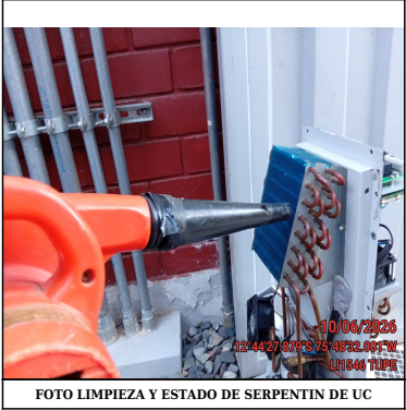
FOTO LIMPIEZA Y ESTADO DE SERPENTIN DE UC
