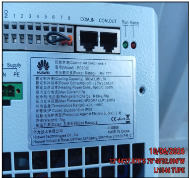
FOTO DE PLACA DE UNIDAD EVAPORADORA
