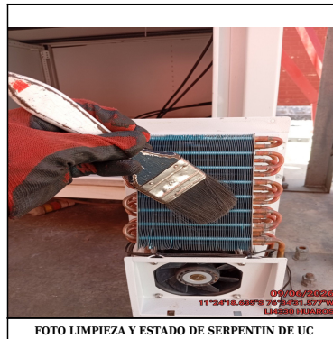
FOTO LIMPIEZA Y ESTADO DE SERPENTIN DE UC
