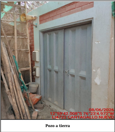
Pozo a tierra
