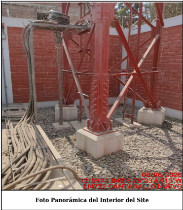
Foto Panorámica del Interior del Site
