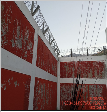
Foto Panorámica del Interior del Site
