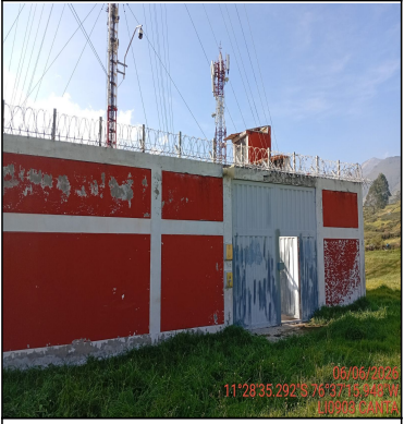
Pozo a tierra
