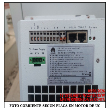
FOTO CORRIENTE SEGUN PLACA EN MOTOR DE UC
