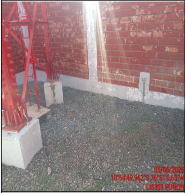
Foto Panorámica del Interior del Site
