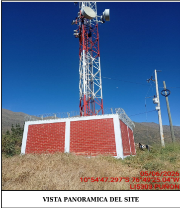
VISTA PANORAMICA DEL SITE
