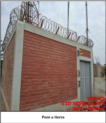
Pozo a tierra
