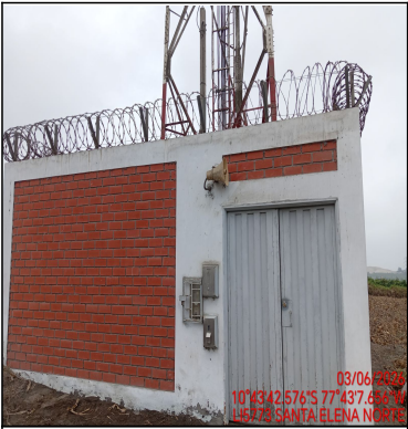
Pozo a tierra
