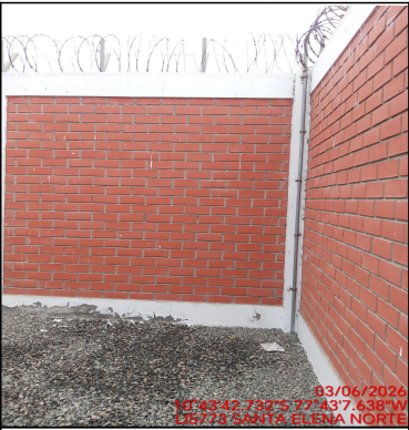
Foto Panorámica del Interior del Site
