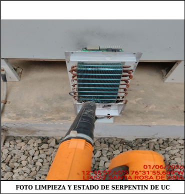
FOTO LIMPIEZA Y ESTADO DE SERPENTIN DE UC
