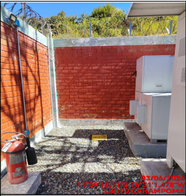
Foto Panorámica del Interior del Site
