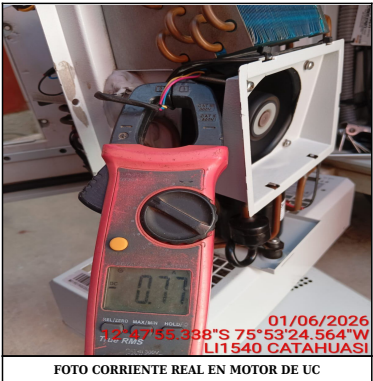
FOTO CORRIENTE REAL EN MOTOR DE UC
