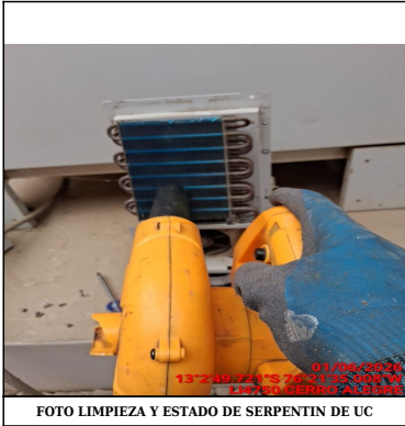
FOTO LIMPIEZA Y ESTADO DE SERPENTIN DE UC
