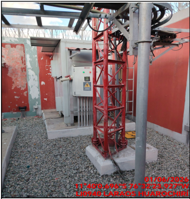
Foto Panorámica del Interior del Site
