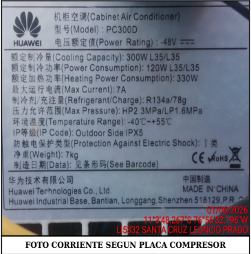
FOTO CORRIENTE SEGUN PLACA COMPRESOR
