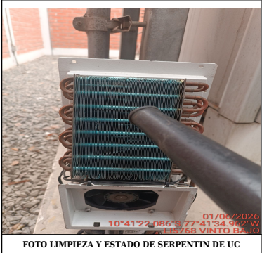
FOTO LIMPIEZA Y ESTADO DE SERPENTIN DE UC
