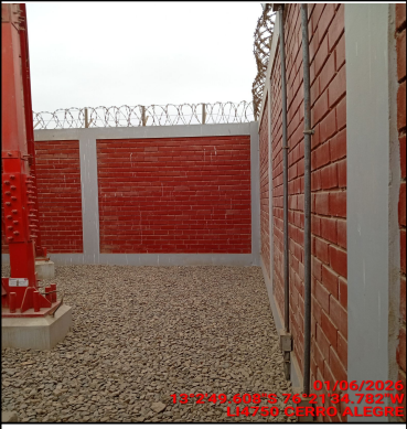
Foto Panorámica del Interior del Site
