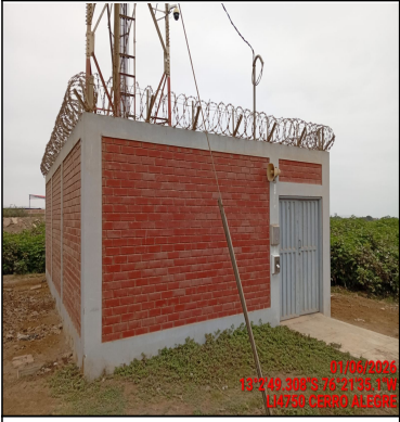
Pozo a tierra
