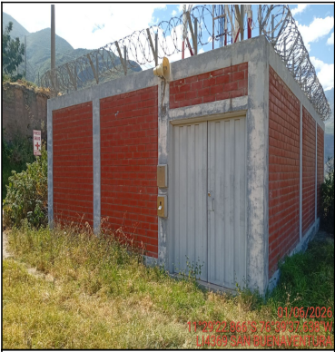
Pozo a tierra
