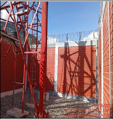
Foto Panorámica del Interior del Site
