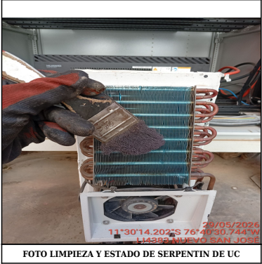
FOTO LIMPIEZA Y ESTADO DE SERPENTIN DE UC
