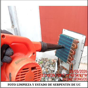
FOTO LIMPIEZA Y ESTADO DE SERPENTIN DE UC
