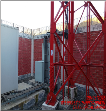
Foto Panorámica del Interior del Site
