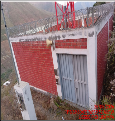
Pozo a tierra
