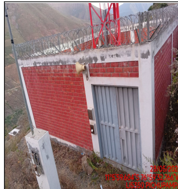
VISTA PANORAMICA DEL SITE
