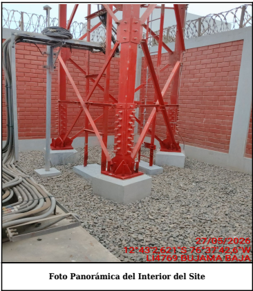
Foto Panorámica del Interior del Site
