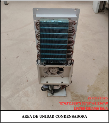
AREA DE UNIDAD CONDENSADORA
