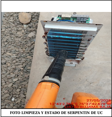
FOTO LIMPIEZA Y ESTADO DE SERPENTIN DE UC
